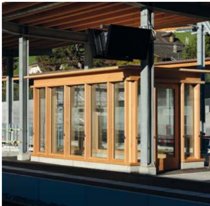
Salle d'attente et marquise de la gare de Château-d'Éx
