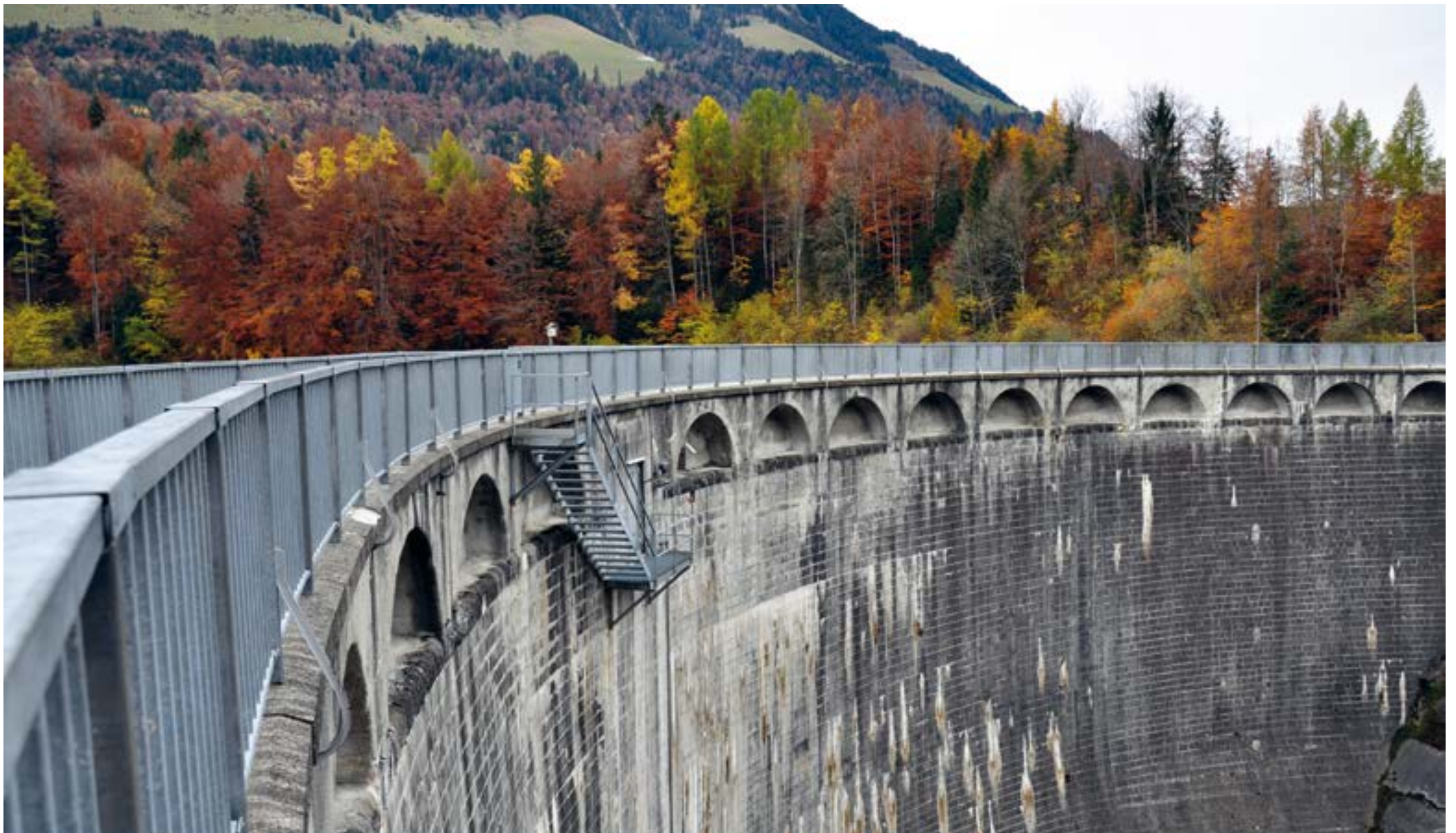
Le barrage de Montsalvens dans la vallée de la Jogne, premier ouvrage en voûte d'Europe en 1921
