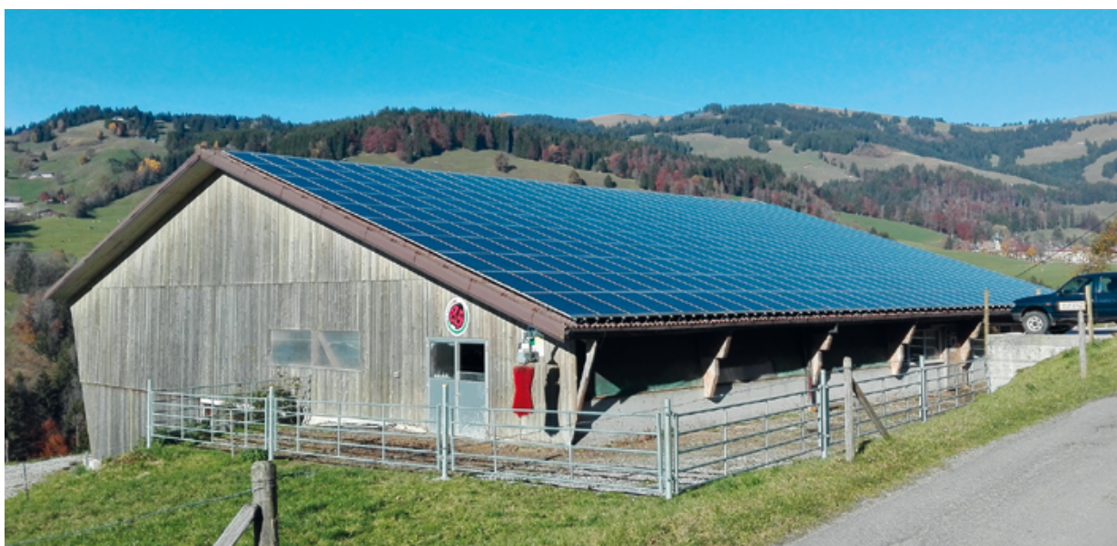
Charmey, ferme des Précomes, installation solaire photovoltaïque
