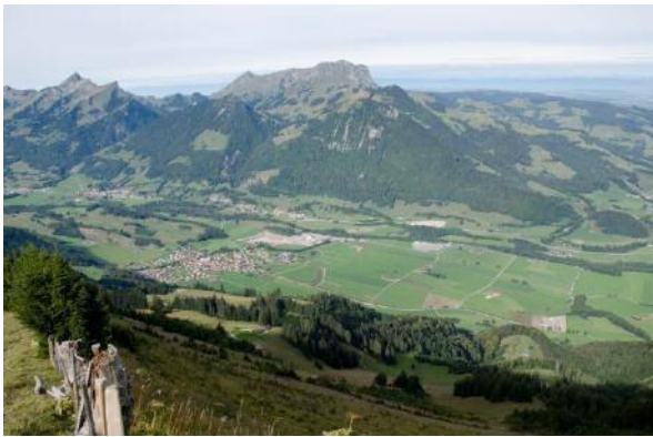
Figure 8 : (Vue sur le Moléson et Grandvillard depuis les Merlas) Le paysage dans lequel la plaine de l'Intyamon est enchâssée présente une grande variété d'éléments, mais la zone à bâtir, les halles industrielles, le cours corrigé de la Sarine et son cordon boisé, la place d'armes ainsi que la gravière prennent une place importante dans la plaine elle-même. (•)
