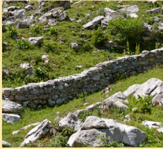
Mur en pierres sèches de Paray-Charbon, Château-d'Ex
